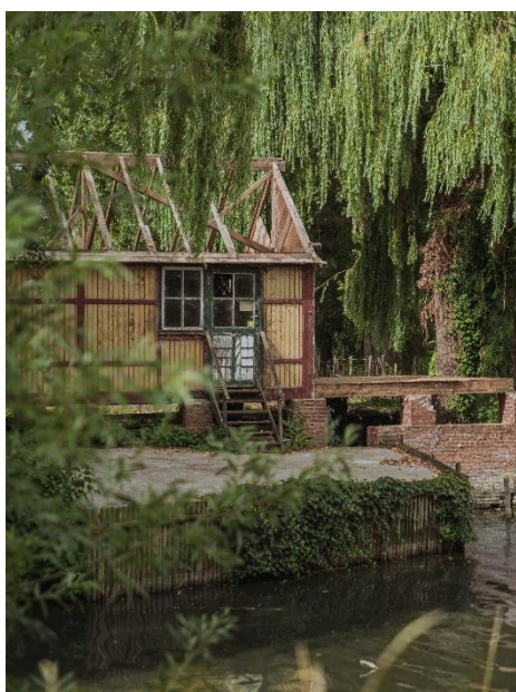
Figuur 1 Voorbeeld van een project uit de vorige LEADER periode, “Toegangspoort Grote Geule” – renovatie van het boothuis als bestaand kleinschalig erfgoed.
